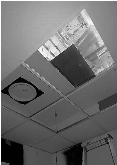
Kuva 2. Mittaushuone, jossa levyjä asennettuna kattoon.
