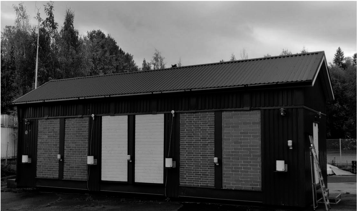
Kuva 1. Rakennusfysikaalinen koerakennus Tampereen Hervannassa. Pohjoisjulkisivu. Vasemmassa reunassa näkyvä masto on osa sääasemaa.
